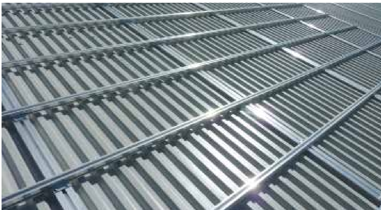
La sottostruttura può essere sollecitata dalle dilatazioni del metallo
