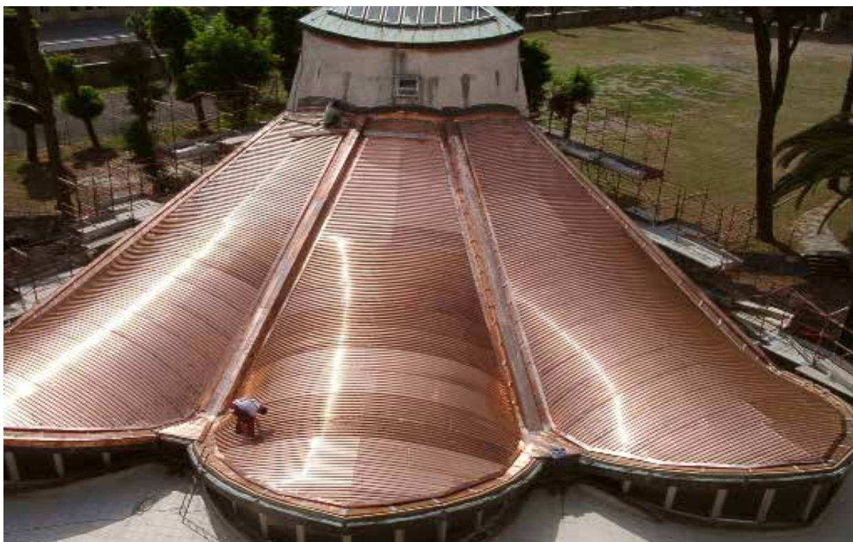
Manto in rame realizzato con lastre grecate
