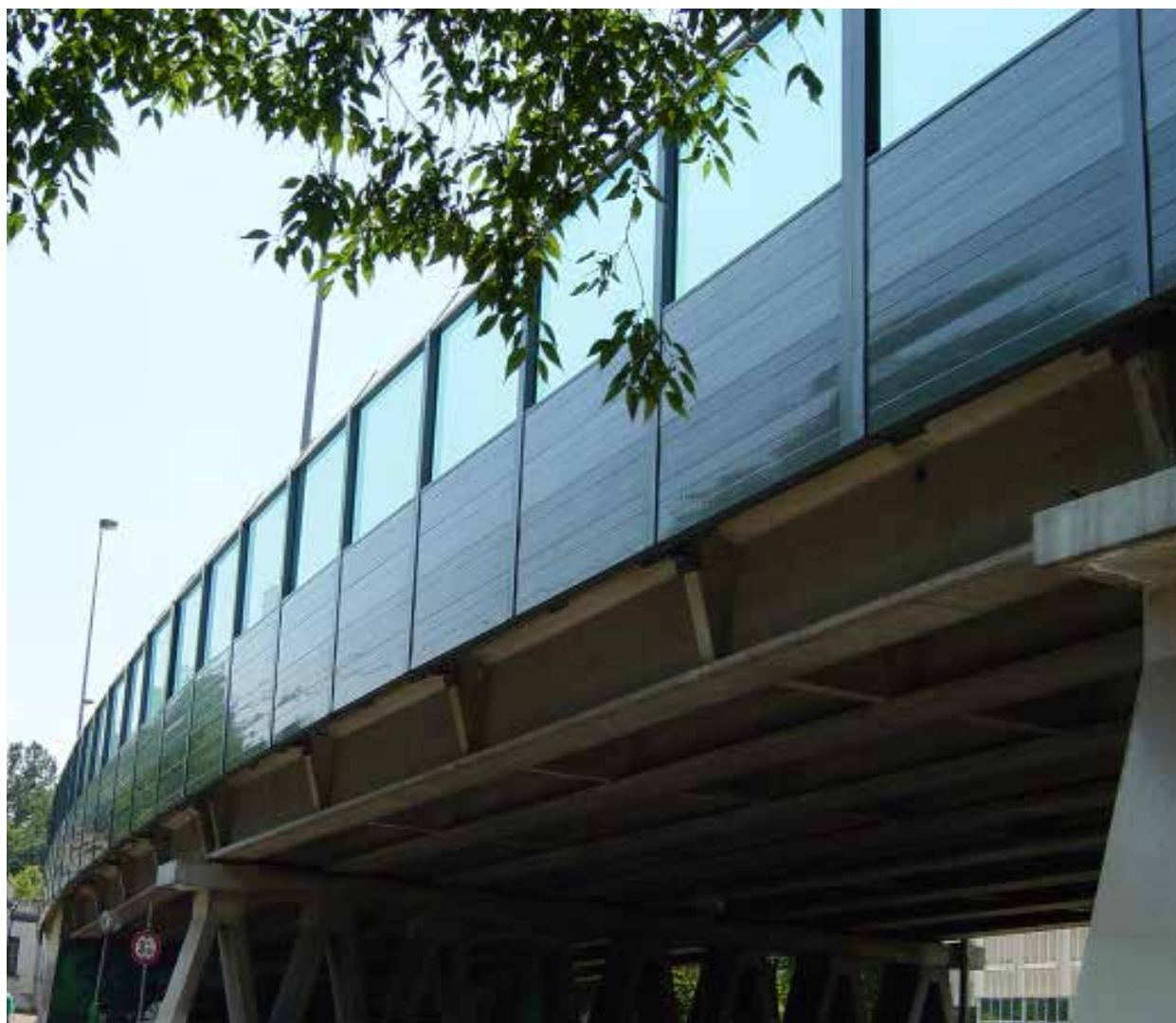
Barriera fonoassorbente a protezione dai rumori di linea ferroviaria
