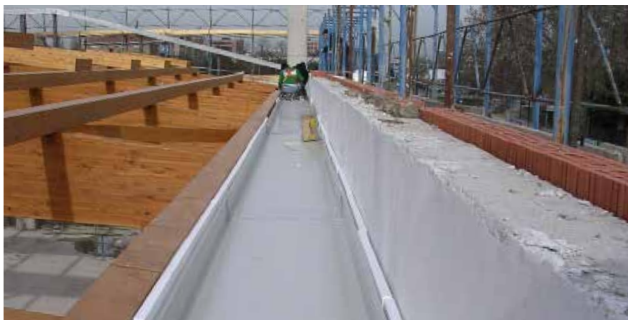
Interposizione di strato isolante tra sede del canale e canale stesso
