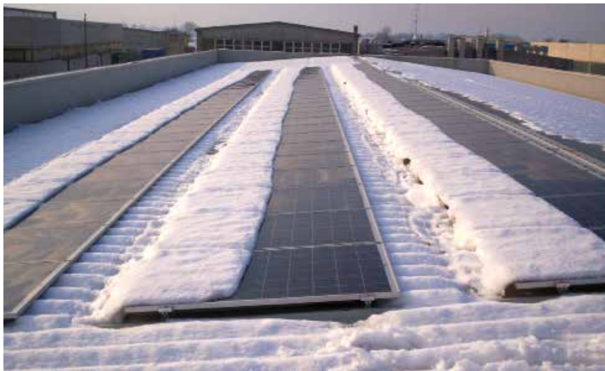
Esempio di accumulo di neve su impianti fotovoltaici
